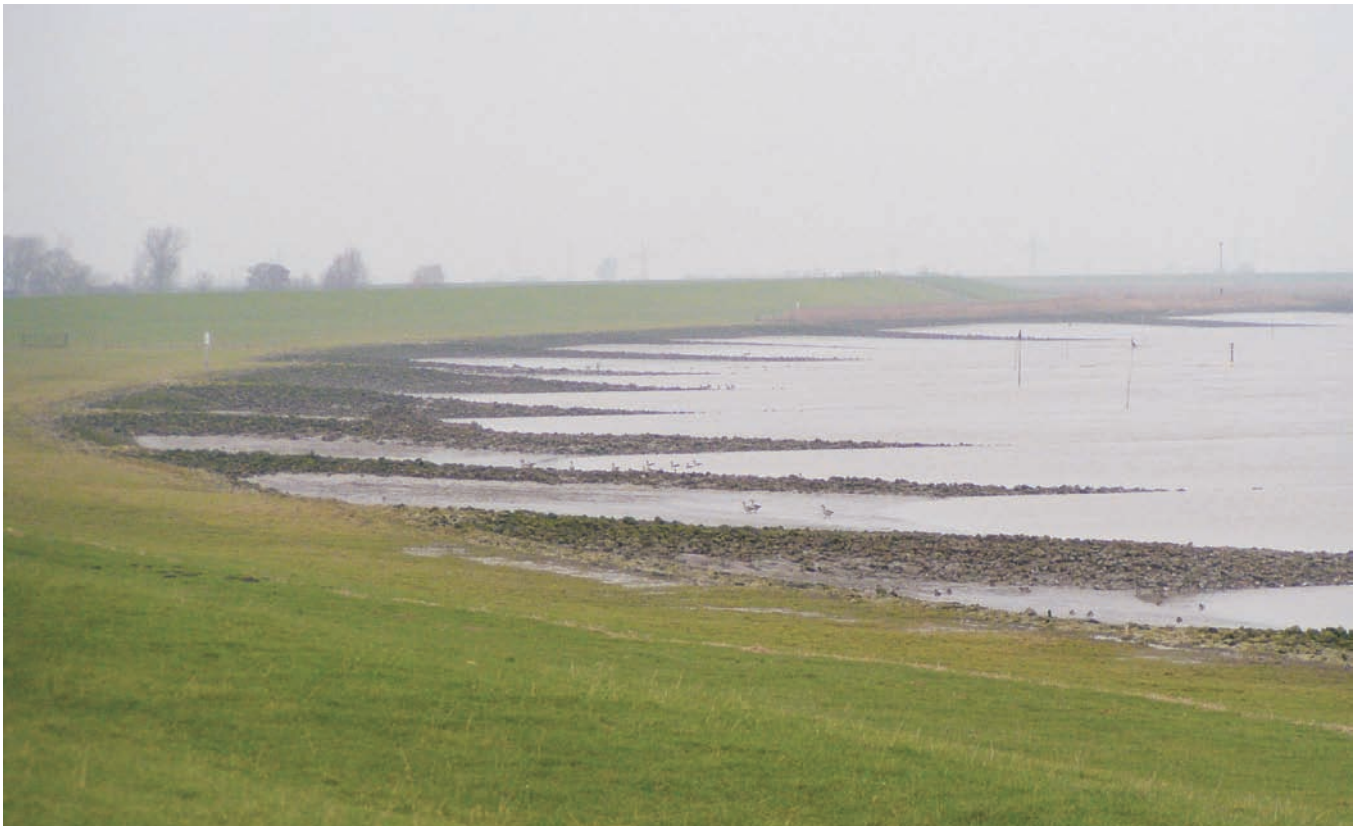
Abb. 0: Uferbefestigung und Bunnen an der Ems. Foto: B. Claus.
